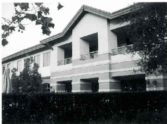
Fig. 4 R2 テクノロジー社外観
